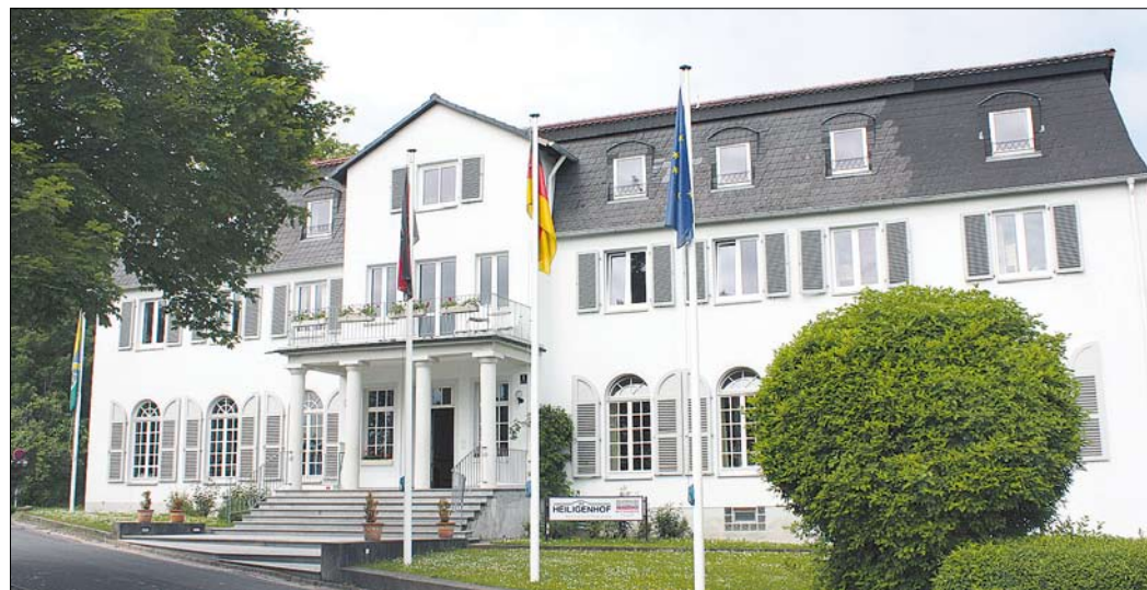
Das historische „Heiligenhof“-Gebäude ist – in architektonischer Hinsicht – zu „rechtslastig“: Der eine Flügel ist deutlich größer als der andere. Deshalb soll schon bald links ein Anbau entstehen und bis zu sechs Zimmer aufnehmen. Geschäftsführer Steffen Hörntler spricht von einem „Millionen-Projekt“, das in zwei bis drei Jahren verwirklicht werden soll. Foto: Bartl (2)
