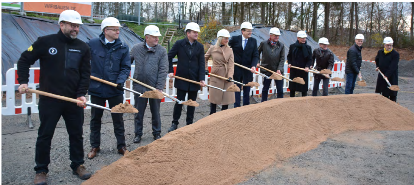
Die Redner und der Stiftungsvorstand beim symbolischen Spatenstich.
